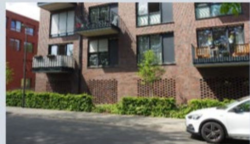
Abb. 38 Integration eines Parkplatzes in das Erdgeschoss in Osnabrück, Foto: BPW Stadtplanung
